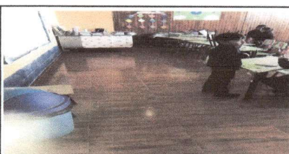
Foto 6: Sustitución por piso Cerámico aula 2
