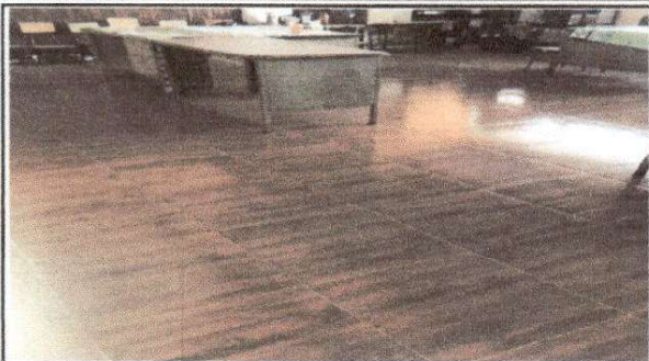
Foto7: Sustrucción por piso Cerámico aula 3
